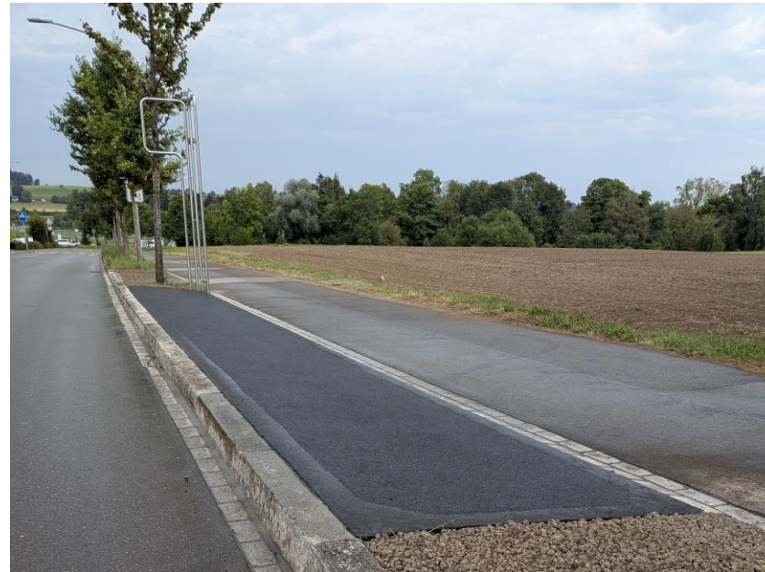
Provisorische Haltestelle Bärenbohlstrasse
