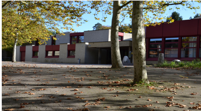
Die Schulanlage Im Isengrind wird erweitert.
